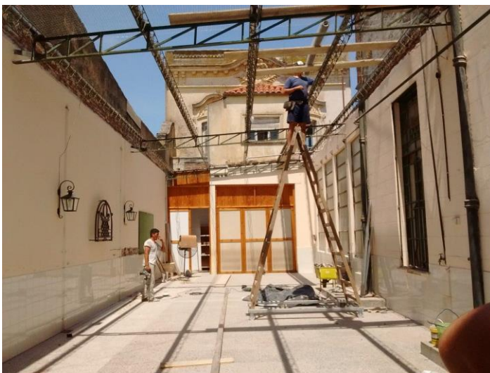
Werkzaamheden in volle gang!
